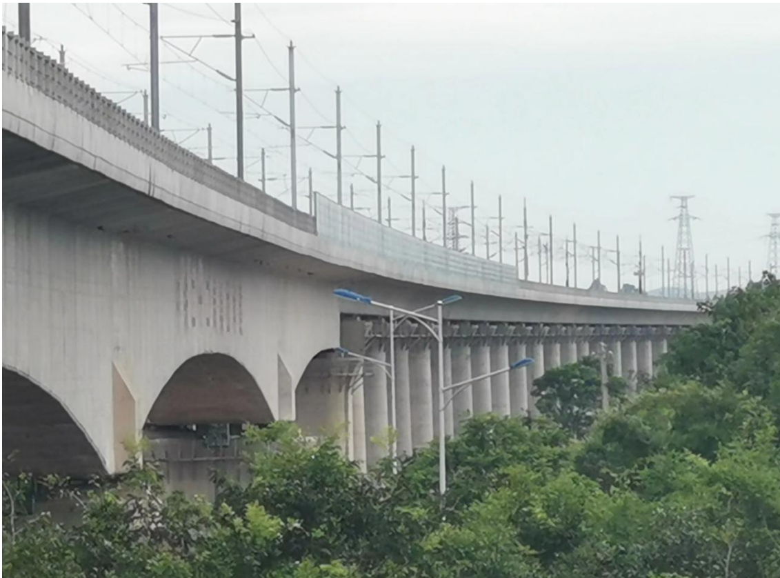
5、吴圩镇平丹小学：平丹特大桥 DK20+200~DK20+510.085 桥梁右侧声屏障
