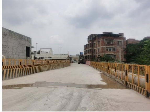
2、NCZQ2 标小里程施工便道
