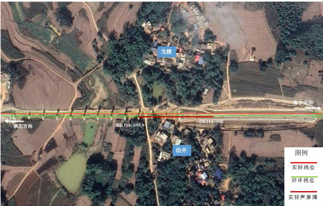
14、元井：DK114+500~DK114+592.06 路基左侧声屏障，元井大桥 DK114+592.06~DK114+695.9 桥梁左侧声屏障
