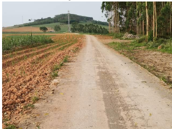
36、NCZQ6 标二管理组便道
