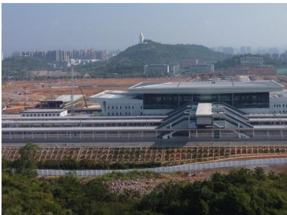
崇左南站站场边坡防护及绿化
