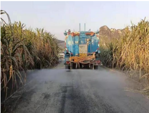
NCZQ5 标铺轨基地施工便道洒水抑尘 (2) 车辆冲洗及施工道路路面硬化绿化
