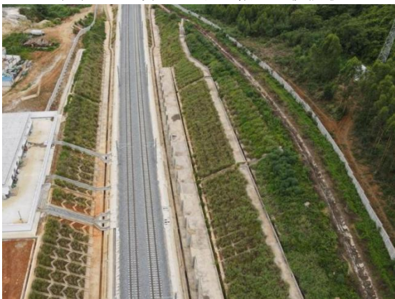
渠督哂特大桥后路基边坡防护
