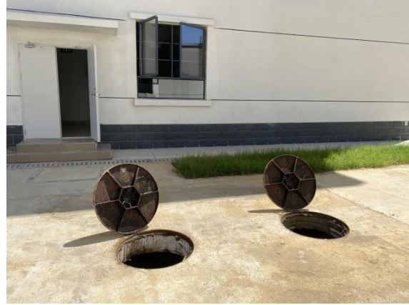
崇左综合工区隔油沉砂池
