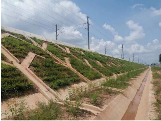
机场隧道出口至朝阳坡大桥间路基护坡及排水沟
