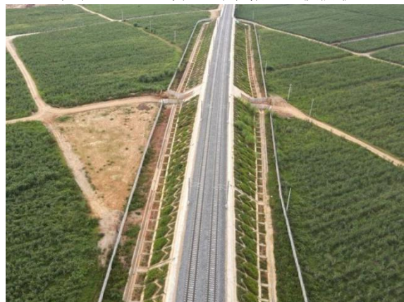
渠芦 2、3 号隧道间路基边坡防护
