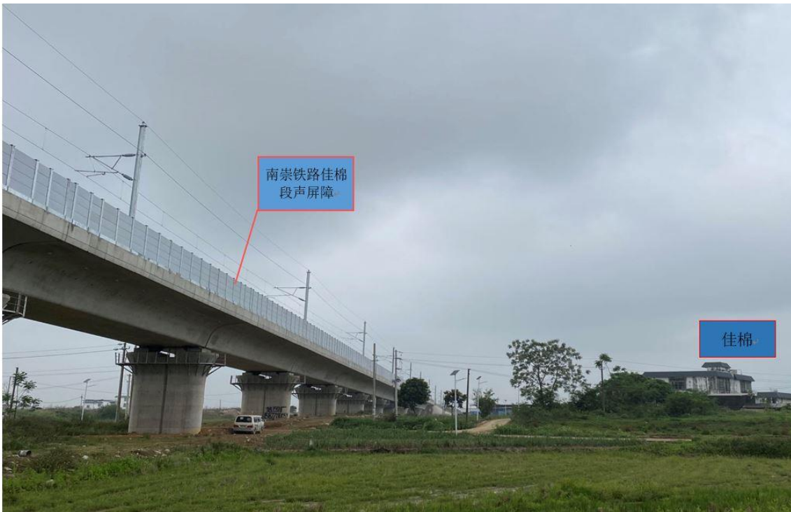
10、佳棉公社：朝阳特大桥 DK36+175.209~DK36+534.917 桥梁右侧声屏障
