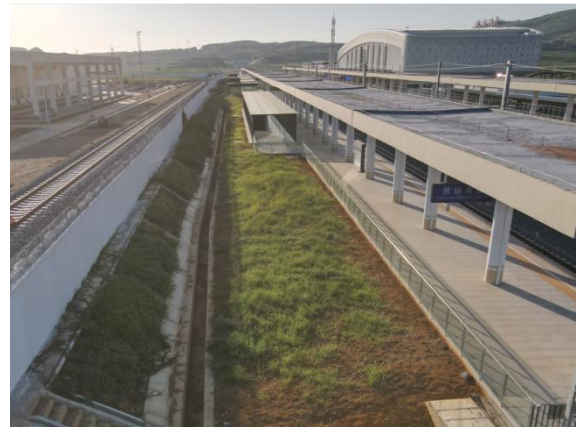
扶绥南站站场边坡防护及绿化
