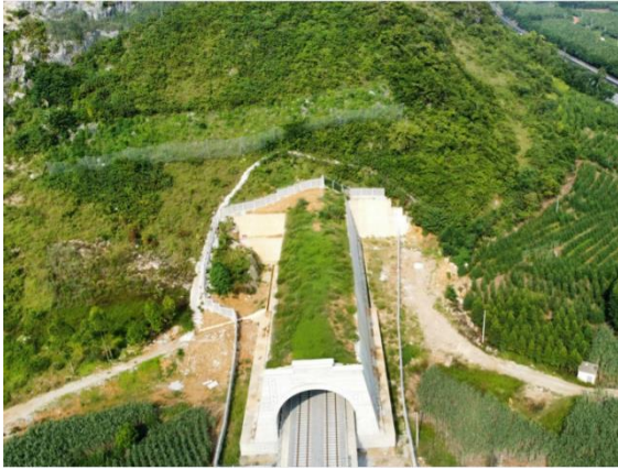
渠芦3号隧道出口
