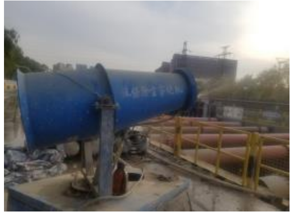
NCZQ1 标 1 号拌合站雾炮抑尘
