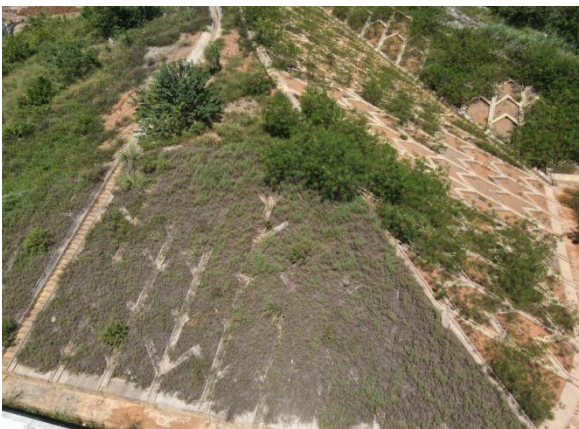
崇左南站站场边坡防护及绿化
