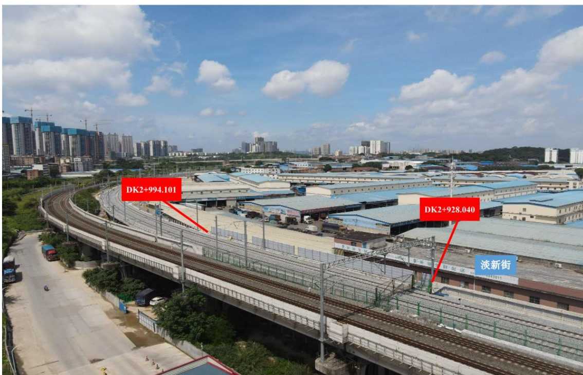
1、新淡街特大桥 DK2+928.04~DK2+994.101 右侧新建声屏障（因施工需要拆除重建）
