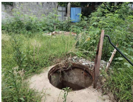
南宁站动车集便污水化粪池
