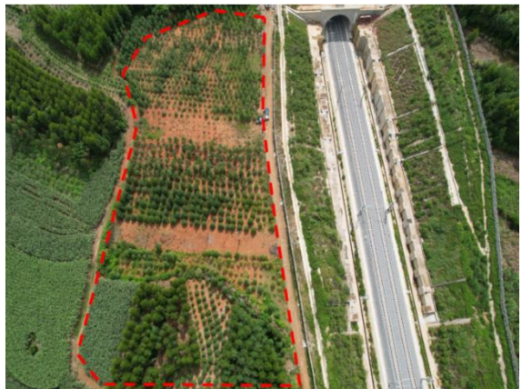
12、DK72+950 甲午山 1 号隧道出口驻地
