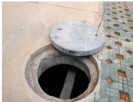
崇左综合工区隔油沉砂池
