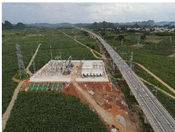
碧计牵引变电所
