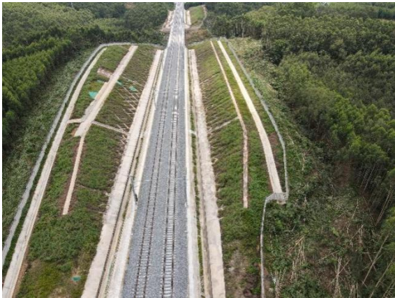
渠那 2、3 号桥间路基边坡防护
