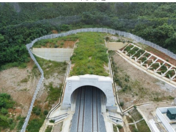
弄忙隧道进口
