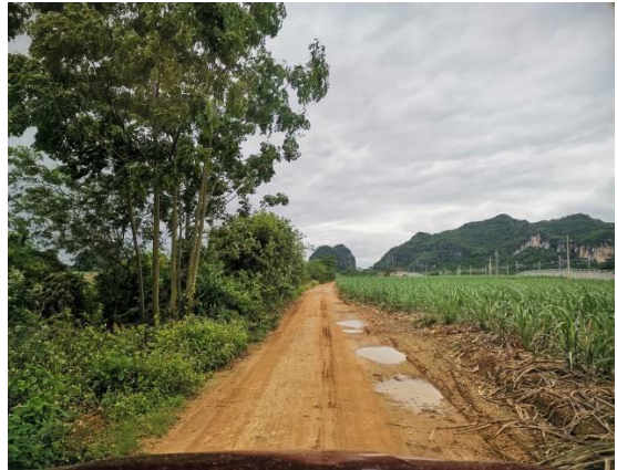
24、NCZQ5 标岜模屯中桥便道
