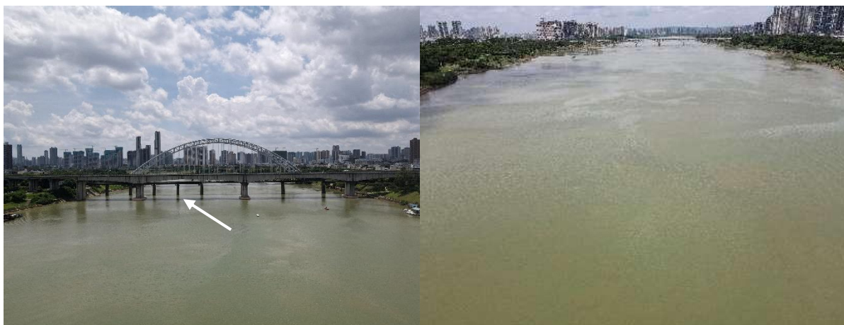
云桂线新南宁邕江特大桥桥位
