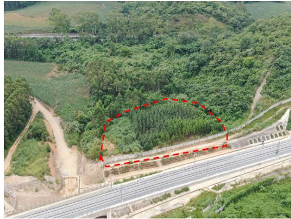
31、NCZQ6 标 DK116+550 戈楼屯隧道驻地
