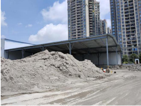
NCZQ2 标泥水处理厂整改前
