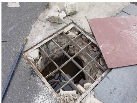
南宁站污水排口
