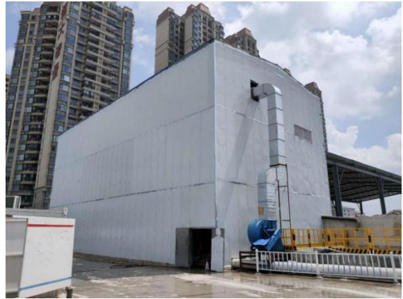
NCZQ2 标留村隧道盾构机入口处隔音棚
