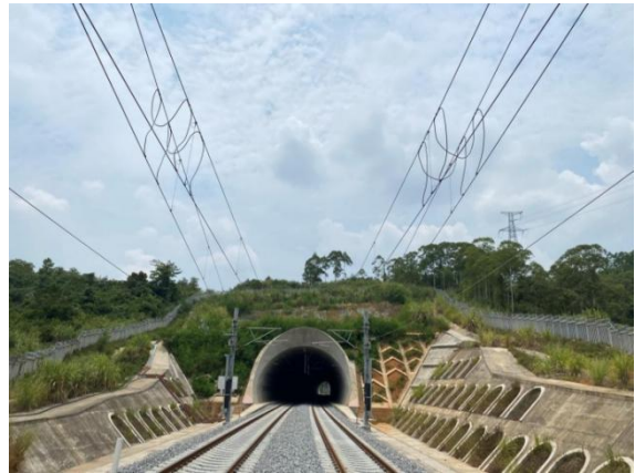
戈楼屯2号隧道进口
