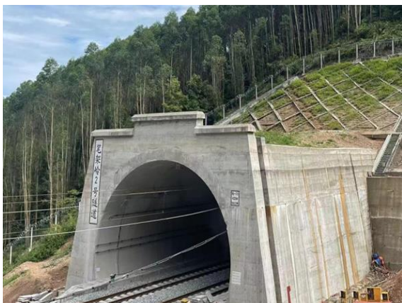
笔架岭 2 号隧道进口
