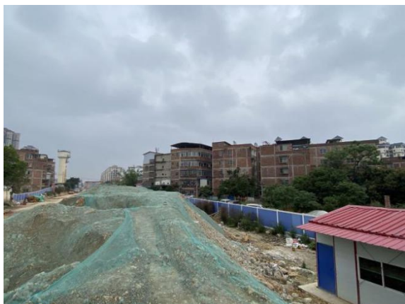
NCZQ2 标留村隧道临时堆土苫布覆盖
