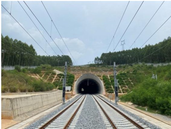
戈楼屯1号隧道出口
