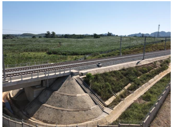
渠马村特大桥桥台防护及路基绿化
