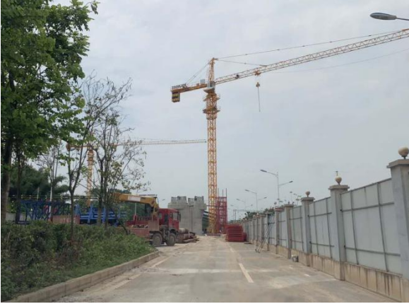
NCZQ1 标跨友谊公路段施工围挡
