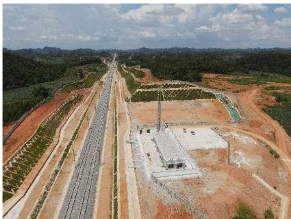
15、渠旧南站基站
