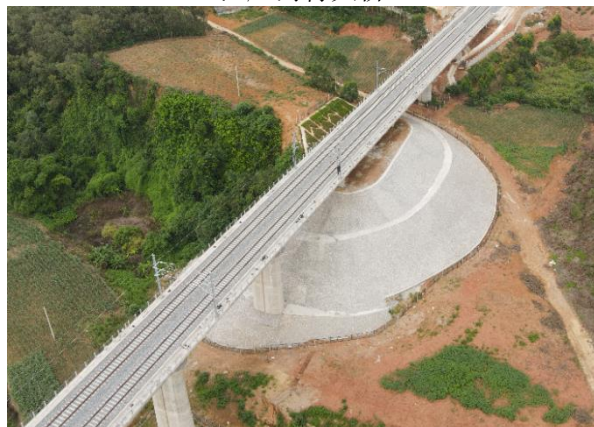
汪庄河特大桥桥下护坡及水中墩防护
