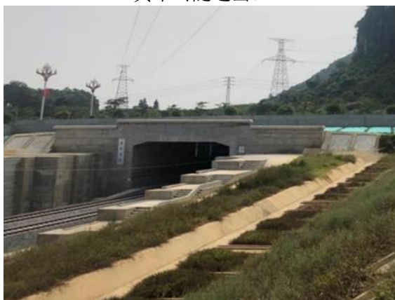
渠那隧道出口
