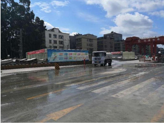
NCZQ2 标留村隧道盾构施工场地洒水抑尘
