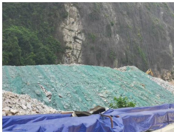
NCZQ5 标弄忙隧道临时堆土苫布覆盖
