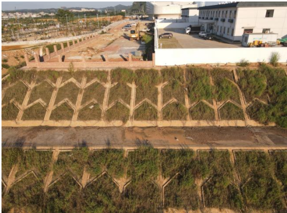
扶绥南站站场边坡防护及绿化
