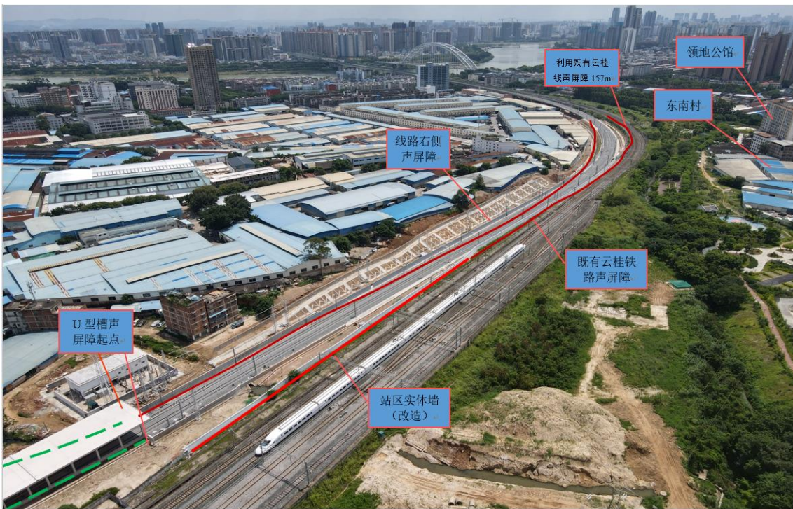
2、东南村、岭地公馆、万兴小学等对应路段 DK3+286-DK4+342 两侧声屏障全景
