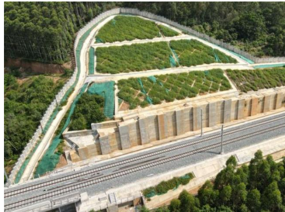
汪庄河特大桥路基边坡防护
