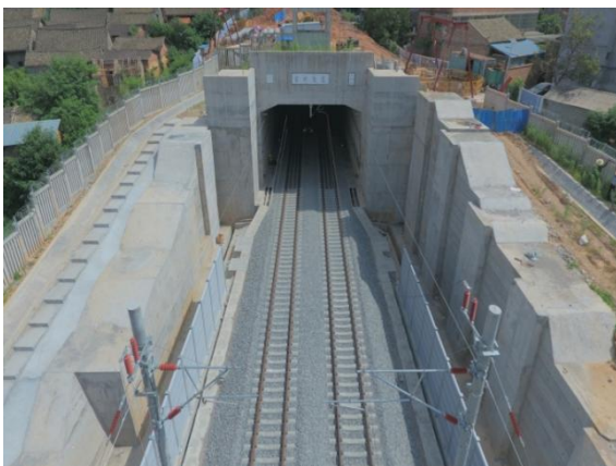
留村隧道出口
