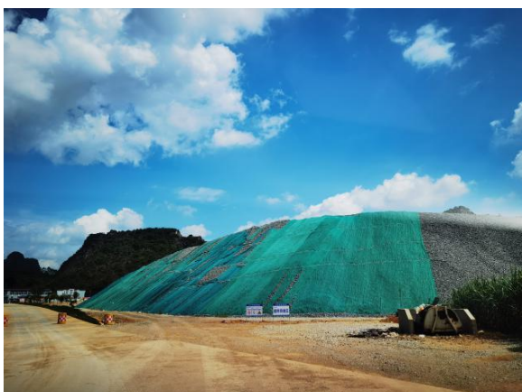
铺轨基地苫布覆盖抑尘
