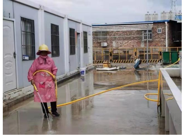
NCZQ2 标留村隧道入口施工点地面冲洗抑尘
