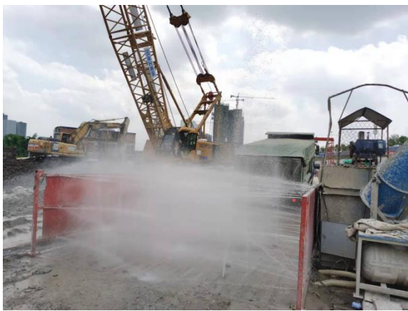
NCZQ2 标留村隧道入口施工点车辆冲洗平台
