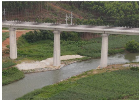
汪庄河特大桥桥下护坡及水中墩防护
