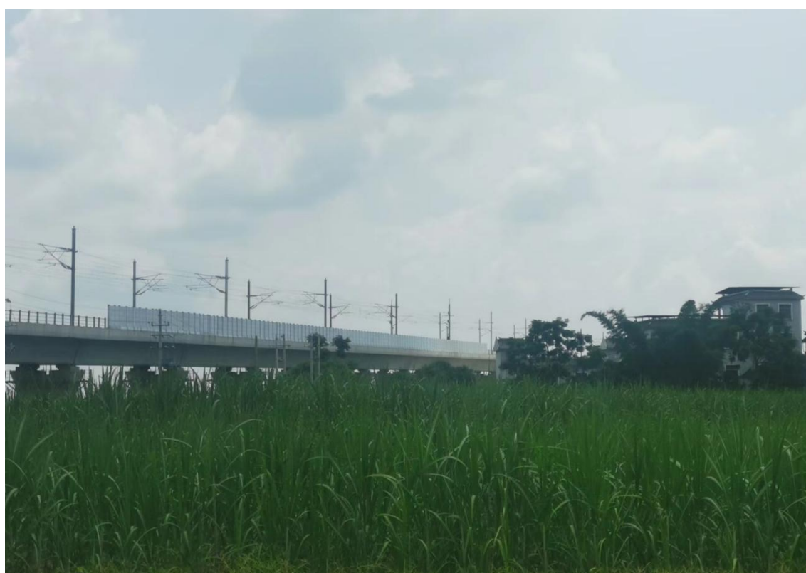
9、朝阳坡：朝阳特大桥 DK34+093.9~DK34+322.882 桥梁右侧声屏障
