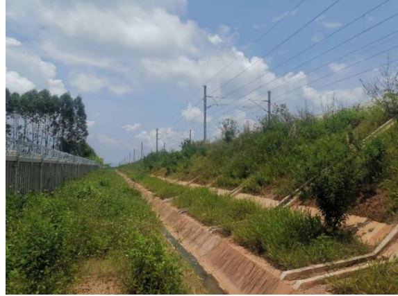
欧村大桥至朝阳坡大桥间路基边坡防护
